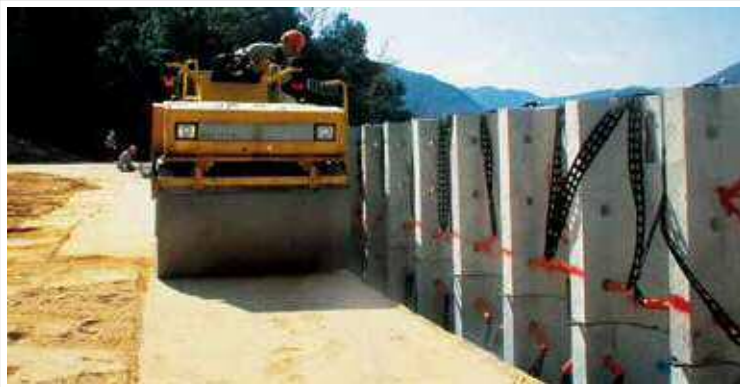
[重機による壁面近傍の転圧状況]
