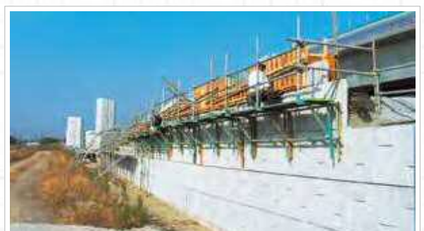
施工時のつり足場設置例
