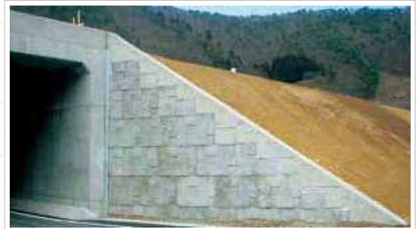
壁面材のデザインにあわせた笠コンクリート(化粧型枠使用)
