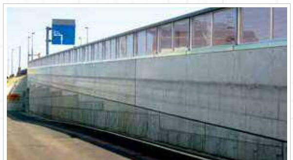
遮音壁の設置例
