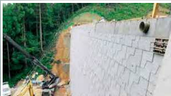
残存型枠の事例
