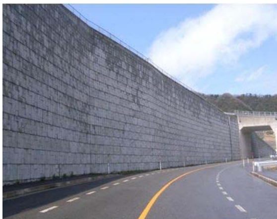
b アダムウォール工法 (コンクリートパネル形式) (二重壁構造を有する垂直補強土壁)
