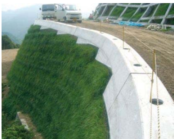
a ユニットキャップ工法 (鋼製枠形式緑化斜壁面補強土壁)
