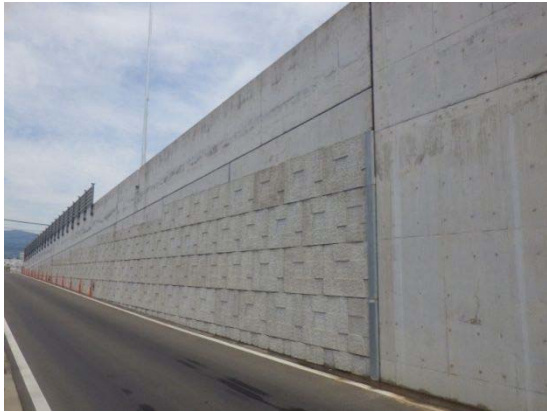
(a) 壁面の状況
