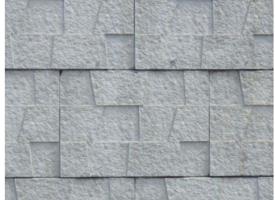
(b) 壁面材の損傷の有無
