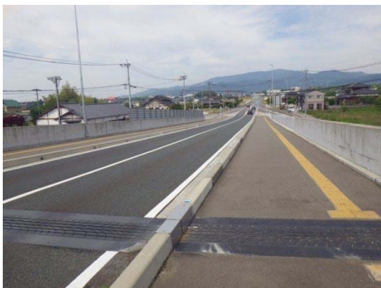
(e) 天端の状況
