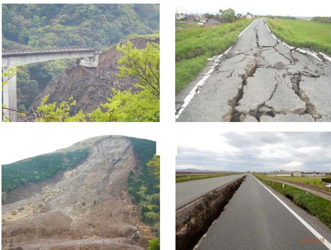
図-1 土木構造物の被災状況 1) 2)
