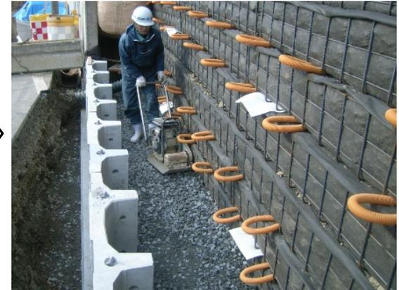
⑨排水層の砕石の敷均し・締固め
