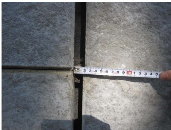
写真-2.2 目地開き量の計測の例
