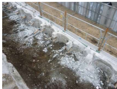
(b) 笠コンクリートの撤去
