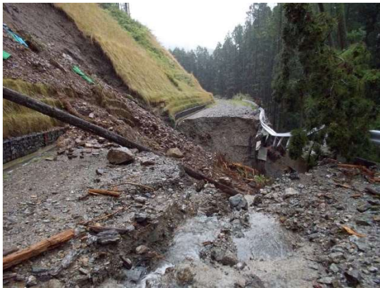
(a) 切土斜面の崩壊と表流水の流入状況
