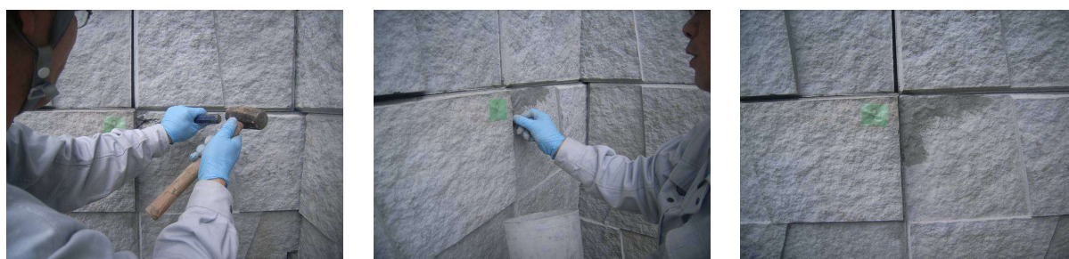
(a) 損傷部のはつり
