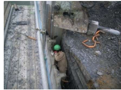
(c) 壁面材の撤去・再設置
