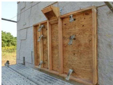
(d) 型枠設置
