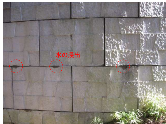
写真-2.3 壁面からの水の浸出の例
