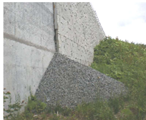
(b) 壁面排水層の碎石のこぼれ出し
