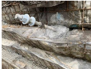
(b) アンカーボルトの打設状況
