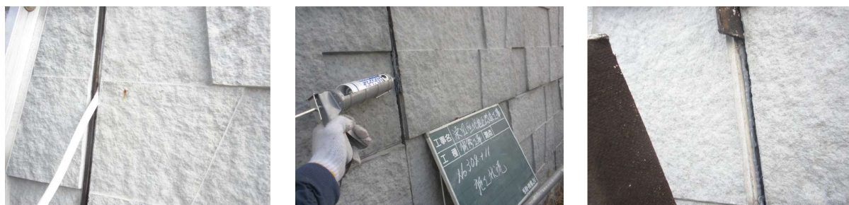
(a) バックアップ材の設置
