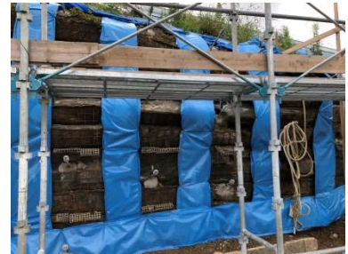
(c) 透水マットの設置
