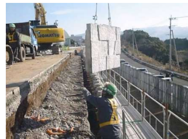
(c) 壁面材の撤去
