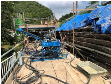
(a) アンカーボルトの打設
