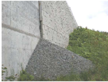
(a) 碎石のこぼれ出し
