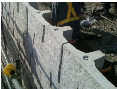
(d) 壁面材の再設置
