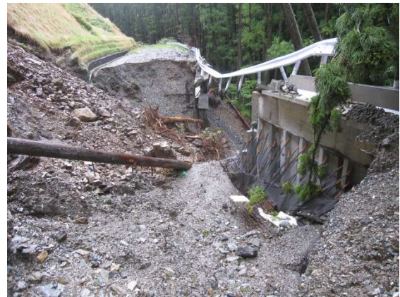
(b) アダムウォールの崩壊状況
