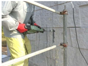
(b) 壁面材の撤去
