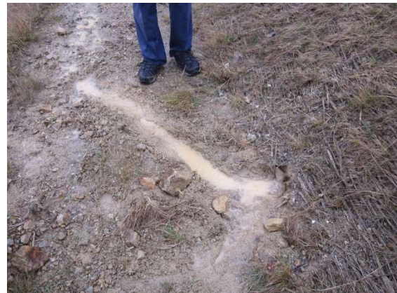
(b) 嵩上げ盛土の小段からの漏水
